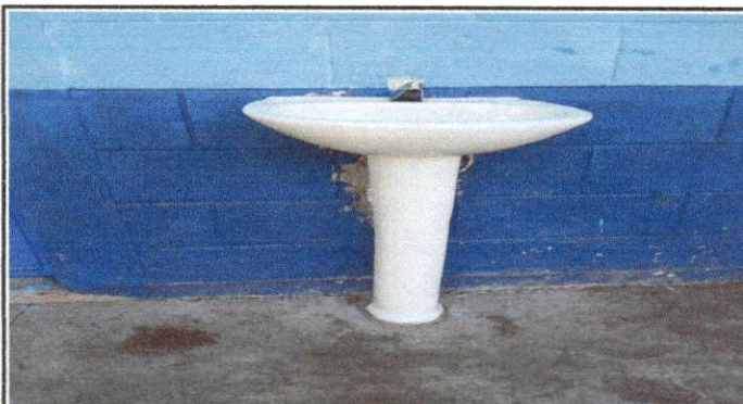
Foto 9: FINALIZACION DE SUSTITUCION DE LAVAMANOS EN MÓDULO 3 DE SERVICIOS SANITARIOS.
