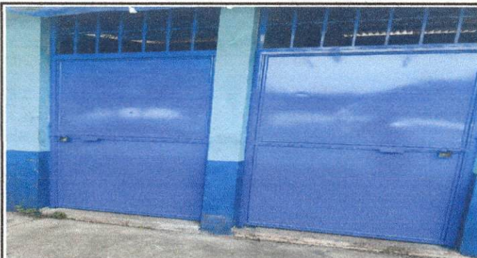
Foto 7: FINALIZACION MANTENIMIENTO A ESTRUCTURA DE PUERTAS EN MÓDULO 3 DE SERVICIOS SANITARIOS.
