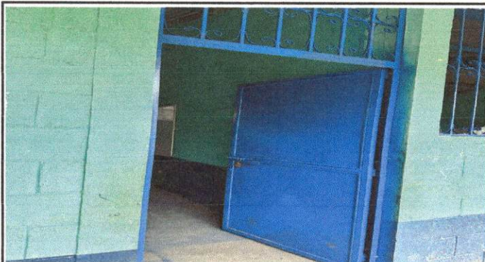
Foto 3: FINALIZACION POR MANTENIMIENTO A ESTRUCTURA EN MODULOS 1 Y 2 DE AULAS.
