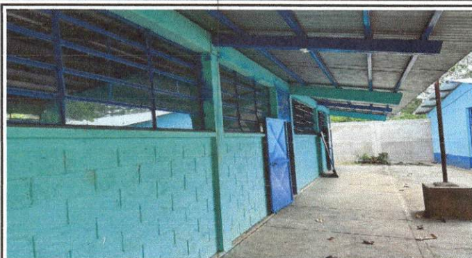
Foto 2: FINALIZACION MANTENIMIENTO A SOPORTE DE ESTRUCTURA DE METAL EN MODULOS 1, 2 Y 6 DE CORREDORES.
