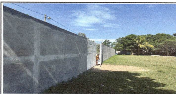
Foto 11: FINALIZACION DE REPELLO EN MURO DE MÓDULO 10 DE BARDA (INTERIOR)
