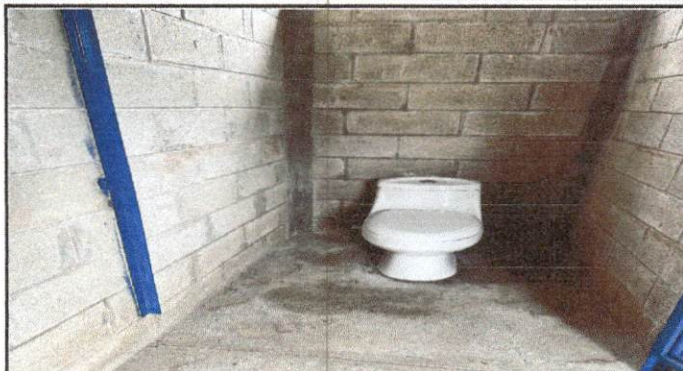
Foto 8: FINALIZACION DE SUSTITUCION DE INODOROS EN MÓDULO 3 DE SERVICIOS SANITARIOS.
