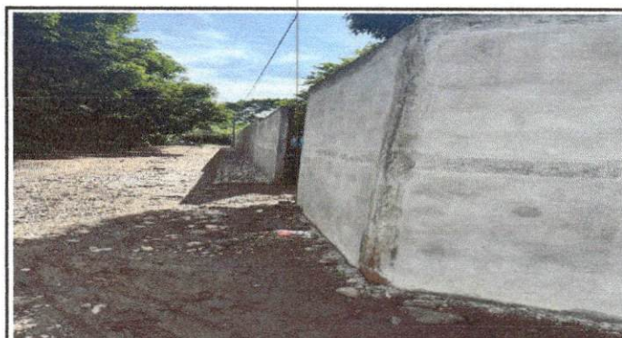
Foto 10: FINALIZACION DE REPELLO EN MURO DE MÓDULO 10 DE BARDA. (EXTERIOR)
