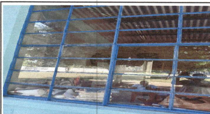
Foto 4: FINALIZACION MANTENIMIENTO A MÓDULOS 1, 2 Y 6 DE AULAS Y COCINA ESTRUCTURA DE METAL DE VENTANAS.
